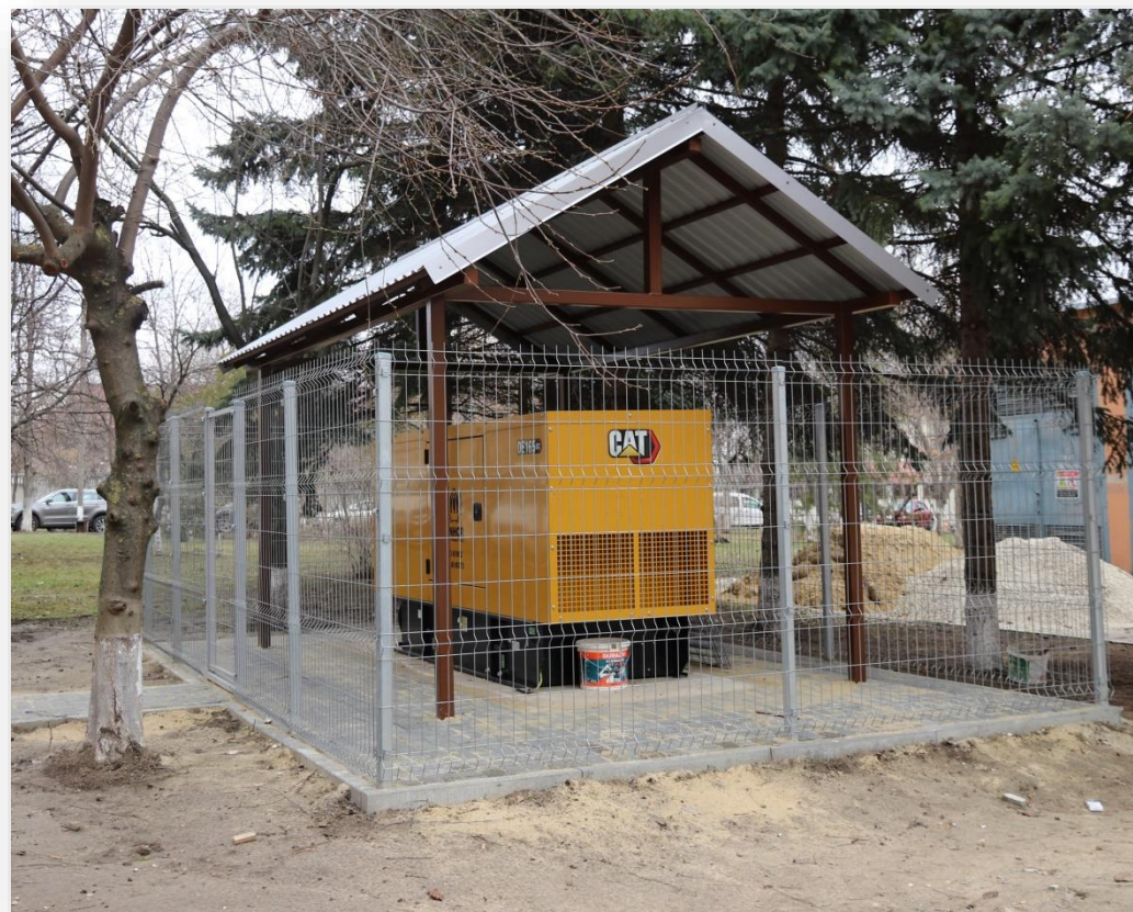
Instalarea generatorului și amenajarea spațiului adiacent
